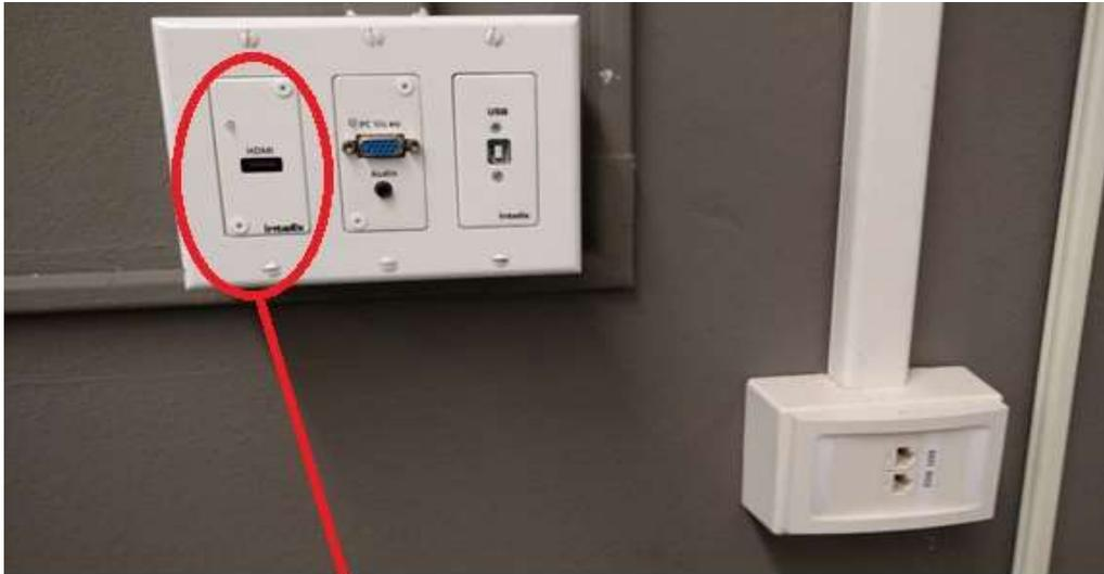
La conexión HDMI pierde funcionalidad porque la moldura se desprende de la placa base. La placa base seleccionada por la compañía AVC no permite el uso de la pizarra inteligente a largo plazo.
